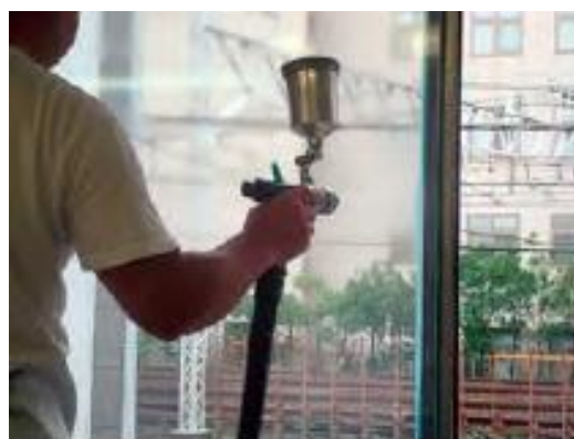
UI-シールドα吹付施工の例
